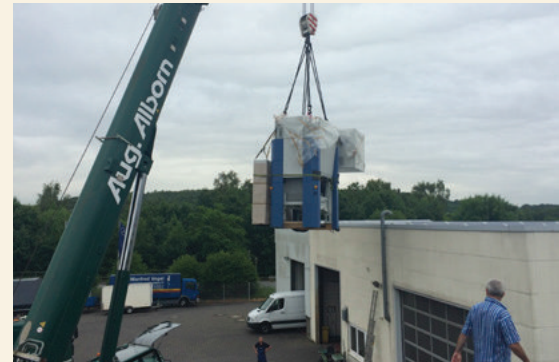
Maßarbeit bei LAS: Neuer Fertigungsautomat schwebt ein.
